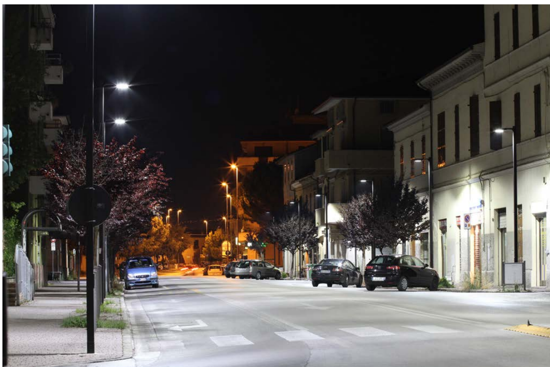
Instalação com luminárias LED com temperatura de cor não superior a 4000 K
